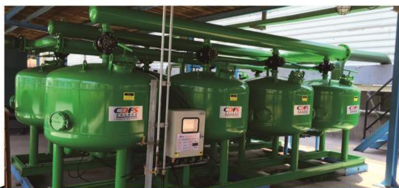
某轮胎企业冷却循环水旁滤
